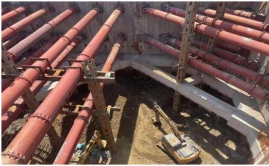
图 2 基坑当前施工俯视图
